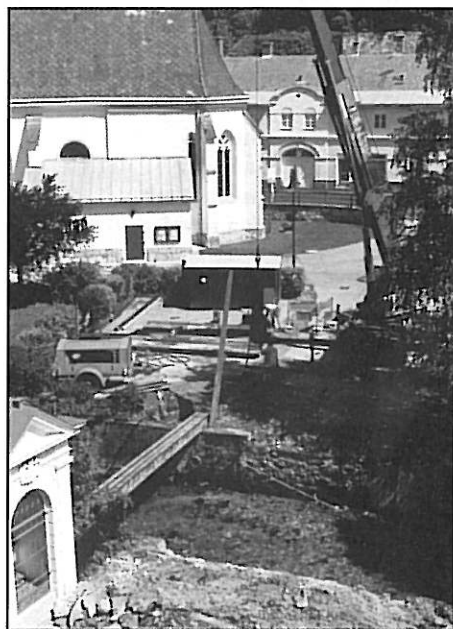
Brückenbau durch geschickten Straßentausch zur Landessache gemacht – Die neue Kirchenbrücke...
