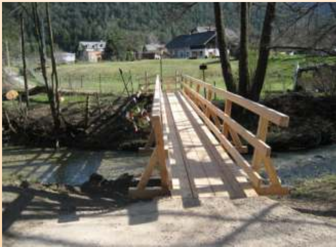
Zwei Eisenträger garantieren nun eine lange Lebensdauer der neuen Brücke.
