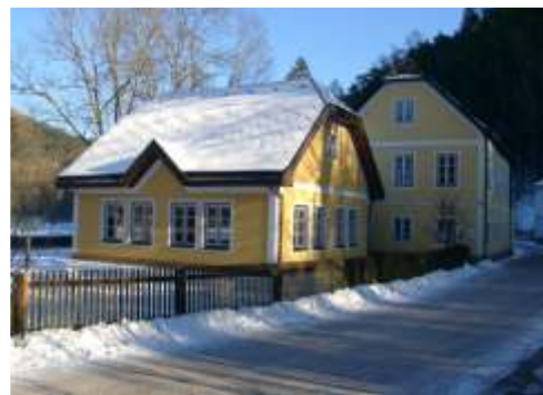
Dritte Kindergartengruppe macht einen Zubau notwendig.
