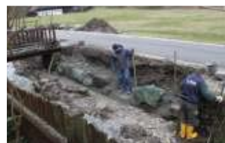
Sanierung der Bachmauer in der Längapiesting
